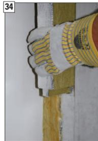
34 Doppelfederplatte in die Nutplatte einstecken.
