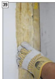
39 Bauseitige Dämmung zwischen der eingebrachten oberen Nutplatte und der Innenwand einbauen.
