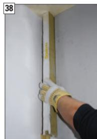
38 Obere Nutplatte in die Doppelfederplatte einstecken.
