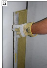
32 Untere Nutplatte des Spezial-KINGFIRE-Rückwanddämmsets hinter die Rückwand der Feuerstätte schieben.
