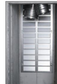
Ansicht des werkseitig eingebauten Strahlungsblechs an der inneren Rückseite der KINGFIRE-Feuerstätte.
