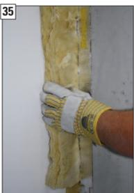
35 Bauseitige Dämmung zwischen der eingebrachten Doppelfederplatte und der Innenwand einbauen.
